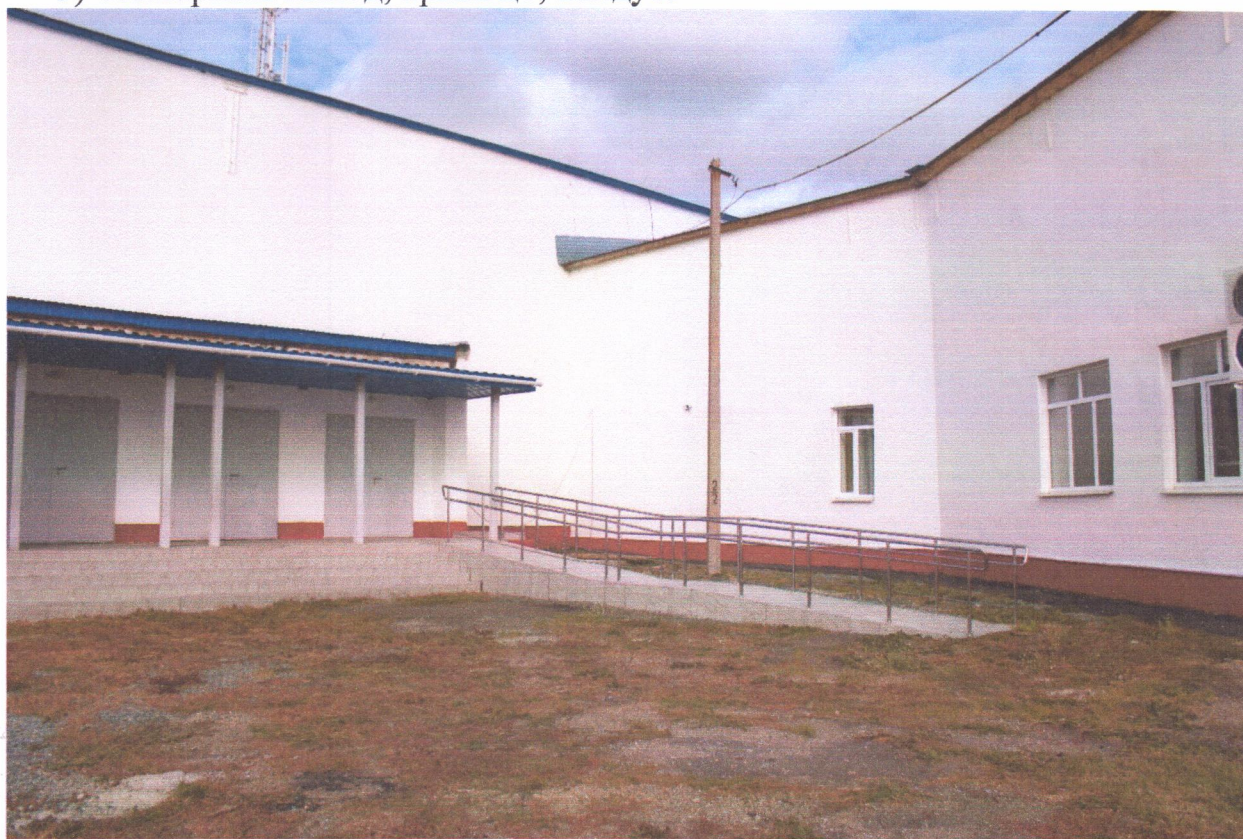
6) Центральный вход, знак доступности учреждения:
